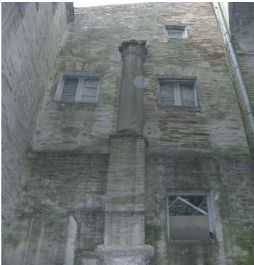
Veduta del cortile interno
