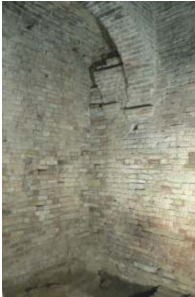
Ambiente interno, resti del sistema voltato
