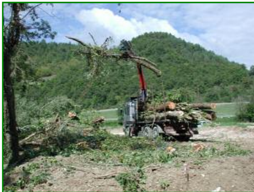
Foto 3 - Il legname è caricato con un autocarro ed avviato al piazzale intermedio
